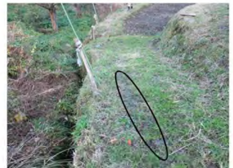
農道(幅はおよそ1.4m)を上から見たところ(楕円のところに木板を敷いていた)
