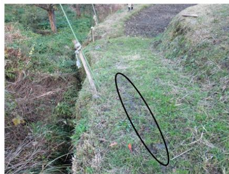
農道(幅はおよそ1.4m)を上から見たところ(楕円のところに木板を敷いていた)
