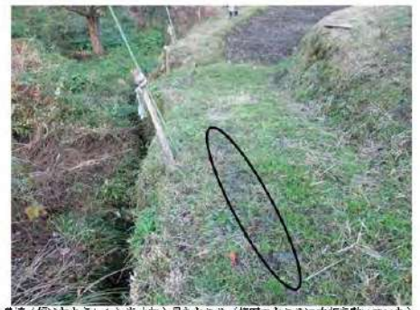
農道(板はおよそ1.4m)を上から見たところ(楕円のところに木板を敷いていた)
